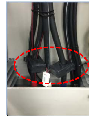
センサ設置状況 (分電盤設置)
