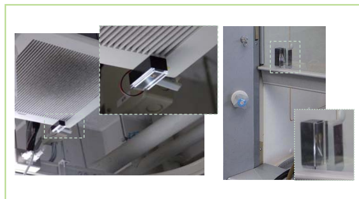
排気システムに取り付けられたセンサネットワーク用VOC濃度センサ
